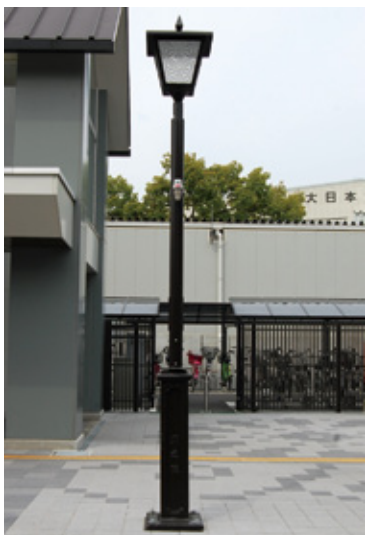
跨線橋の柱を利用した街灯
