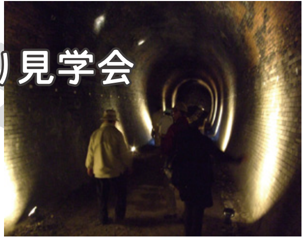
排水トンネル工事中に発掘された亀の瀬トンネル
