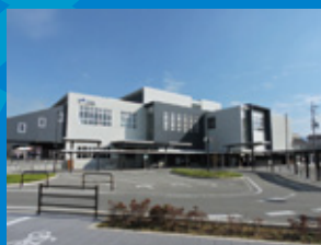
現在の八尾駅(南駅前広場)
